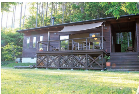
オーナーが、ハーフビルドで建てたカフェのある建物の外観
